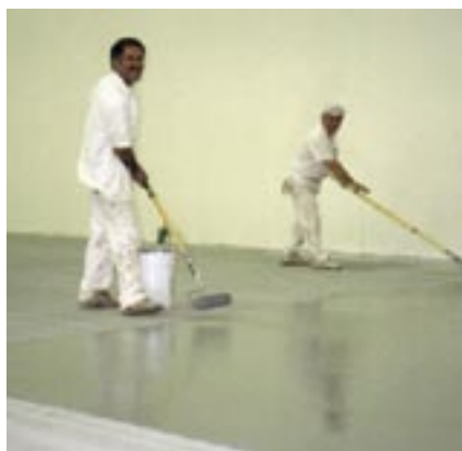
Эпоксидное покрытие 6500 Non VOC является самовыравнивающимся эпоксидным покрытием, разработанным для больших подрядческих применений. Отверждается до сверхпрочного химостойкого покрытия.
