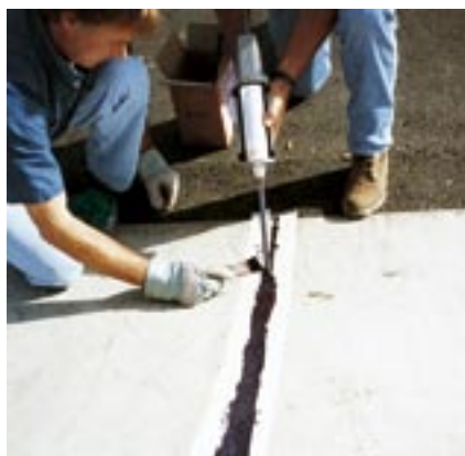
Быстро отверждающийся Flexane® жидкость для ремонта резиновых изделий является серым низковязким уретаном, который заполняет деформационные швы в металле или бетоне.
