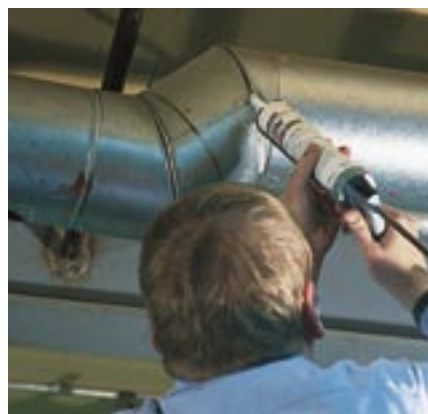
Силиконовый силикон отверждается до эластичного материала напоминающего резину, который не трескается и не сморщивается. Он идеально подходит для герметизации труб нагревания, вентиляции и кондиционирования воздуха.
