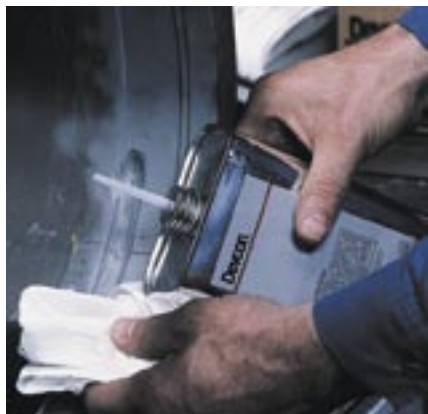
Если поверхность масляная или жирная, обезжирьте ее при помощи Devcon Cleaner Blend 300.
