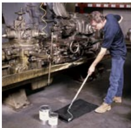
Имея в составе карбид кремния, Заливное напольное покрытие образует исключительно противоскользящую поверхность переходов, платформ, погружных платформ и скользких областей возле машинного оборудования.
