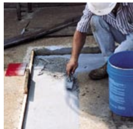
Напольная шпаклевка Devcon является универсальным напольным шпаклевочным компаундом, который в 3 раза крепче бетона. Она быстро отверждается и обладает хорошей химостойкостью.
