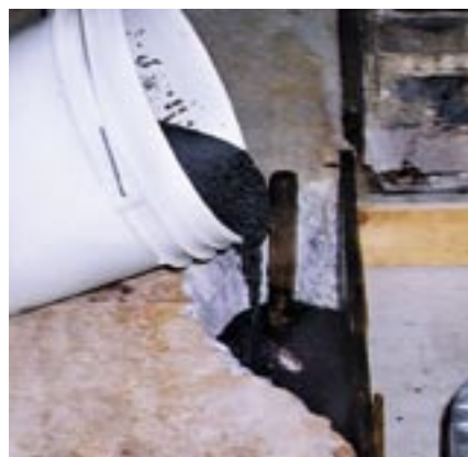
Восстановитель бетона обладает высокой прочностью на сжатие и идеально подходит для установки машинных анкерных болтов.
