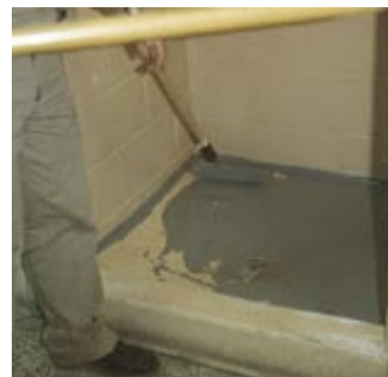
Безопасный Т-абразив является противоскользящей добавкой, смешиваемой с любым защитным напольным продуктом, для предотвращения случайного скольжения.
