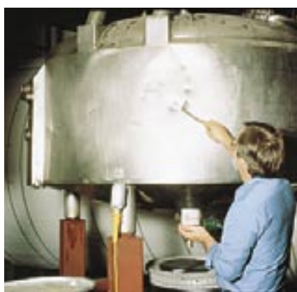
Шпаклевка с наполнителем из пластичной стали идеально подходит для коррозионностойкого ремонта деталей из нержавеющей стали в пищевой промышленности.
