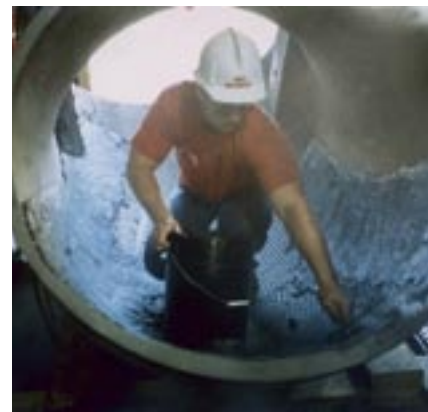
Нанесенная на металлическую сетку, приваченную стежками временной сварки Защита от износа при максимальной нагрузке обеспечивает превосходную защиту от истирания в угольном золоудалющем трубопроводе.
