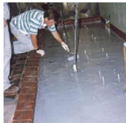
Эпоксидное покрытие 7000 Non VOC является 100% твердым покрытием, которое наносится на гладкие или средневыщербленные бетонные полы и образует красивую долгосохраняемую поверхность.
