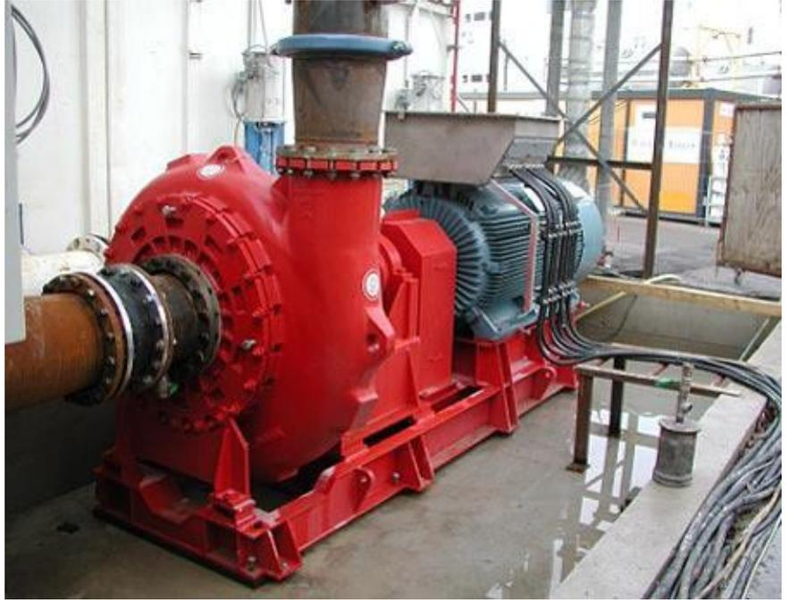
Согласно дефектной ведомости было необходимо: произвести ремонт либо замену “улиты” насоса, заменить рабочее колесо, заменить подшипники, шайбы, болты, гайки, вкладыши.
